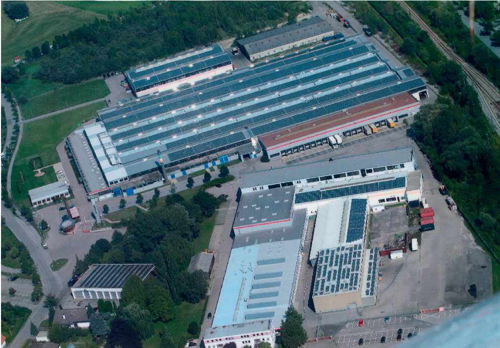
Maximale Abdeckung mit Fotovoltaik-Modulen im Werk Landau an der Isar
